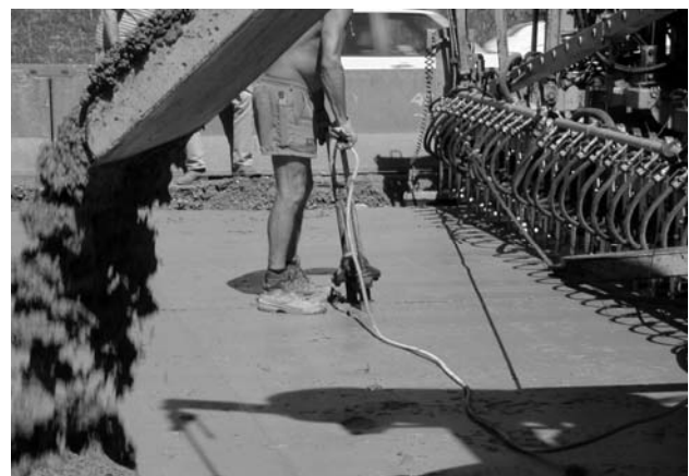
2. ábra A felső betonréteg beépítése csúszózsalsus technológiával, balról jobbra haladva
