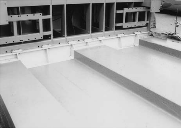
7. ábra Zúzalék nélküli vágányépítés
