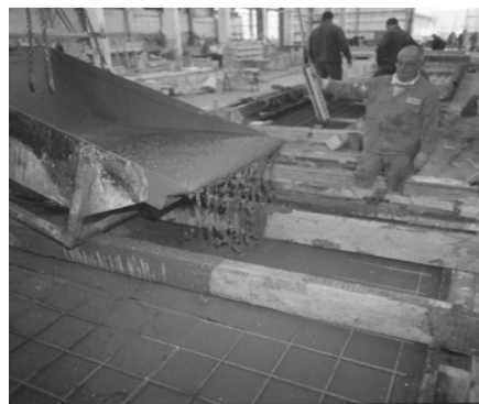
7. ábra Betonozás előregyártó üzemben
