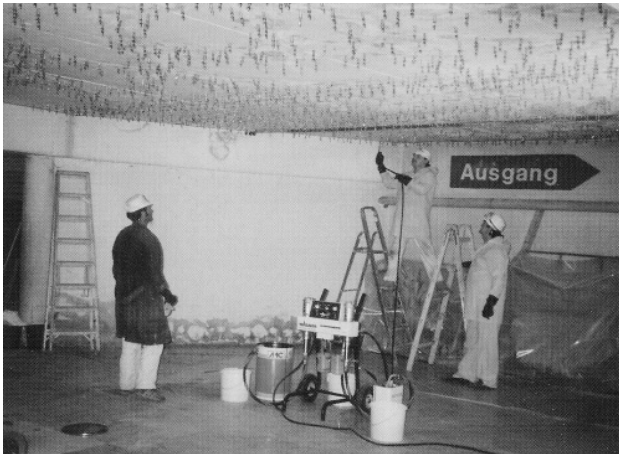
5. ábra Mélygarázs födémének vízszigetelése (Linz, Ausztria)
