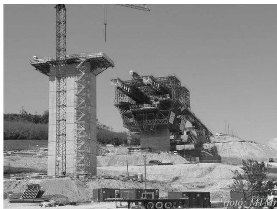
3. ábra Egy épülő pillér
