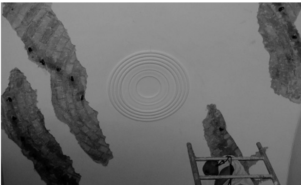
4. ábra Az injektálás folyamata a BMGE K épületében
