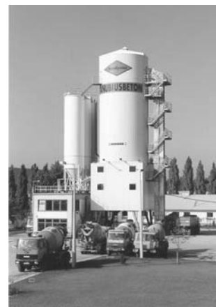
Betonüzem, Budapest Bojtár utca
