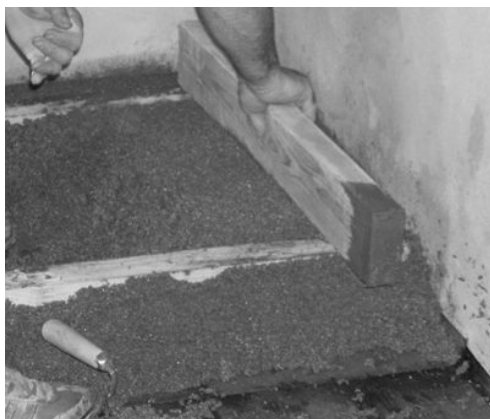
1. ábra Bedolgozás íves pallóval
