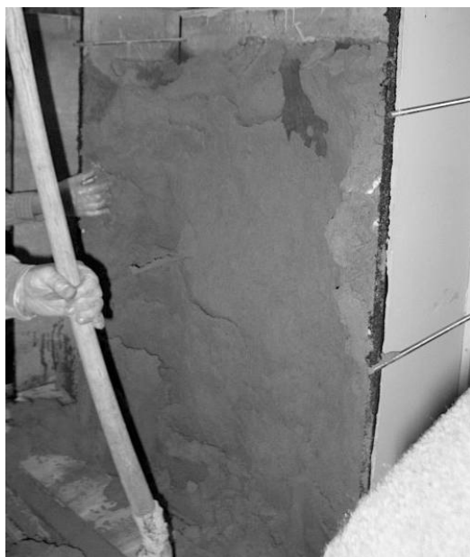
6. ábra A feltárt háttérinjektálás
