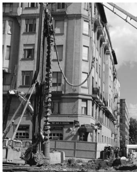
4. ábra A cölöp helyének kifűrése CFA fúrógéppel
