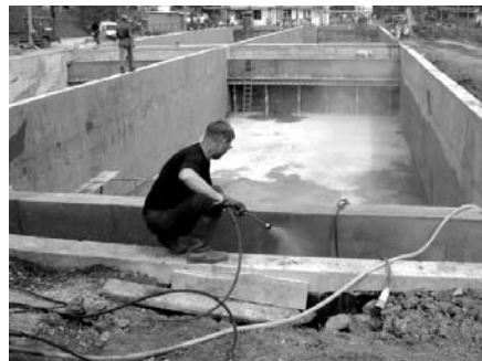
1. ábra Szennyvíztisztító medence betonfelületének előkészítése
