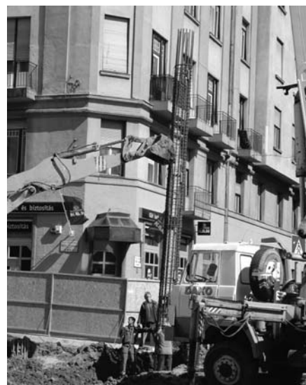
5. ábra A betonacél armatúra leengedése
