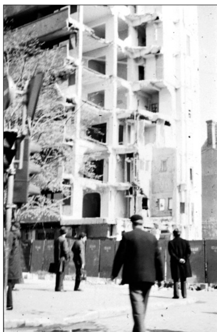
2. ábra Magas épület szerkezetének sérülése
