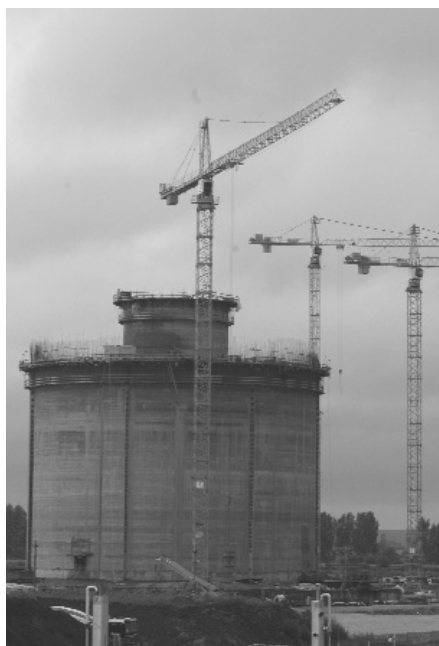
3. ábra A csúszószszalus technológia megköveteli a nem ragadós, hosszan eltartható, ennek ellenére kötésekkésleltetés mentes adalékszer cement kombinációt
