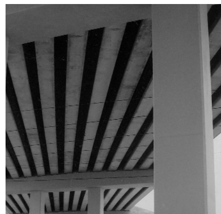
1. ábra A terhek elosztása hídderendák egymás mellé sorolásával
