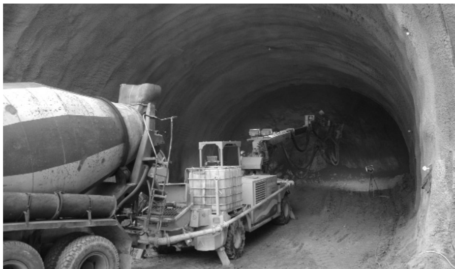
1. ábra Sika PM-500 berendezés használata az M6 autópálya alagútjainak építésénél
