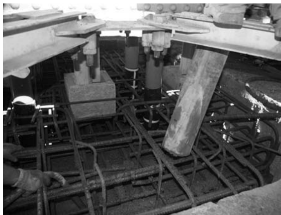
3. ábra Betonozási közelkép
