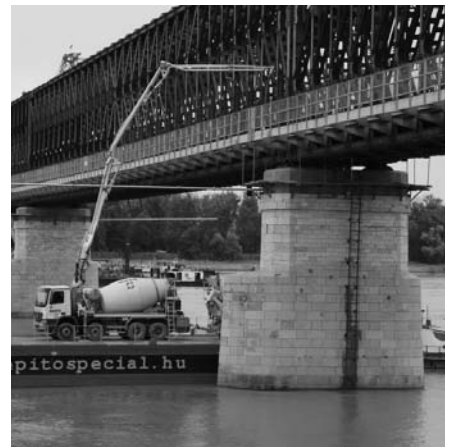
2. ábra Betonozás a VII. pillérnél a beúsztatott mixerkocsival
