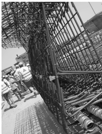
4. ábra Vasalási részlet távtartókkal és feszítőkábel üreggel
