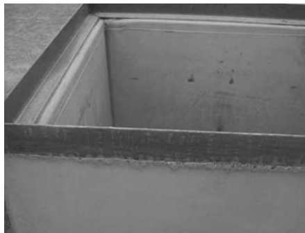
13. ábra Látható pórusoktól mentes, látszóbeton felület egy külön vízzáró adalékszer nélkül is XV3 vízzáróságú (vízbehatolás 3-10 mm között), C 55/67-re adódó szilárdsági jelű, gánti dolomitúzalékból készített vasbeton szerelőaknáknál (selejtarány: 1/500 db)
