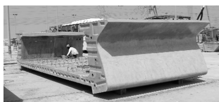
5. ábra Az elem kész, kisebb javítást igényel
