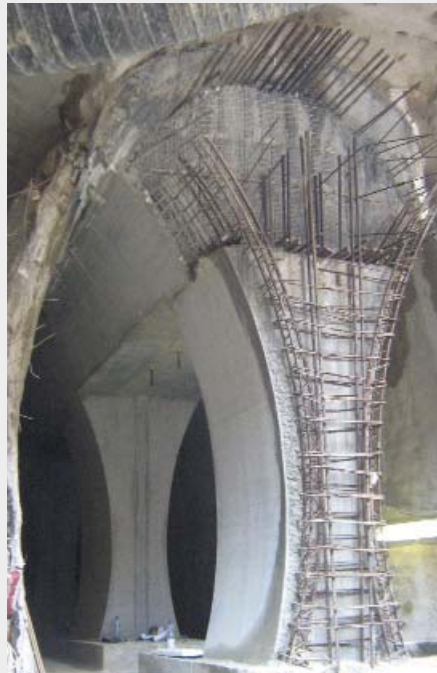
3. ábra A peron és a csarnok közötti pillérsor a Rákóczi téren
