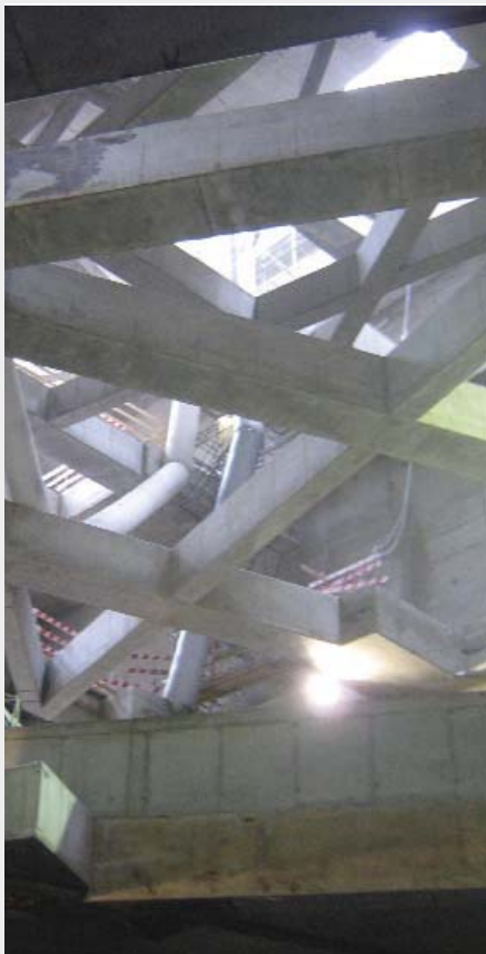
2. ábra A Fővám téri állomás látszóbeton gerendái (szeptemberi állapot)
