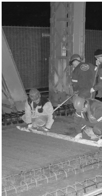
2. ábra A beton bedolgozása, a felület simítása
