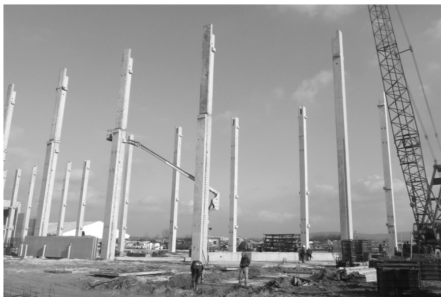
5. ábra A 16 m hosszú pillérekre ráépítették a 8 m toldást
