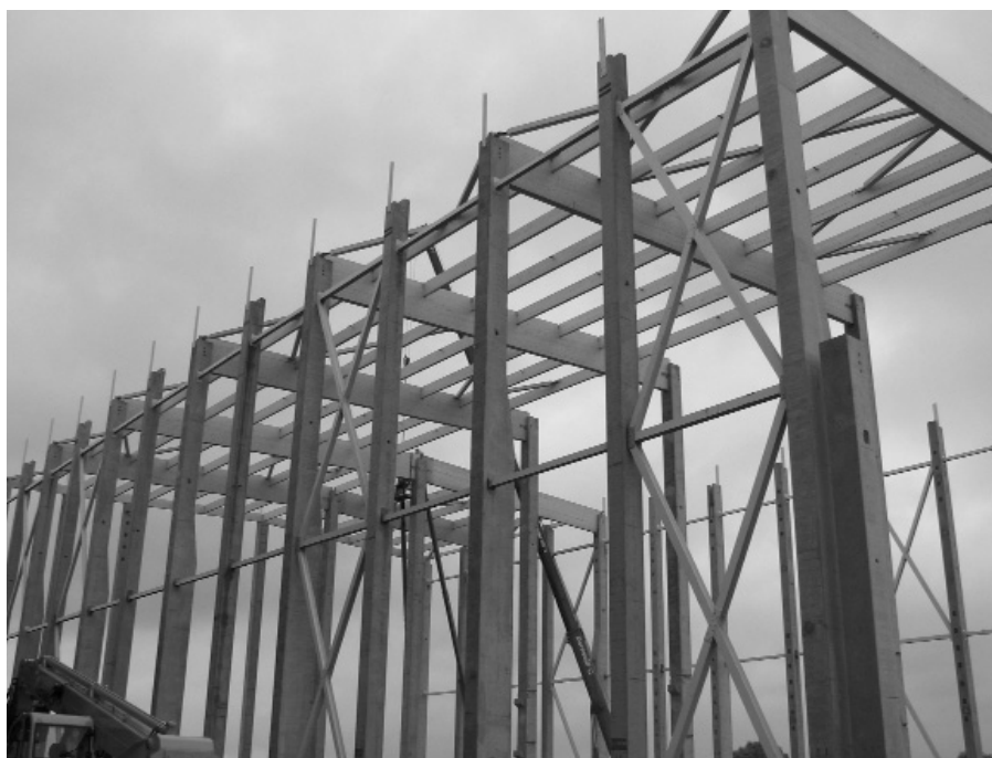
2. ábra Brassó: vasbeton pillérek, fa gerendák
