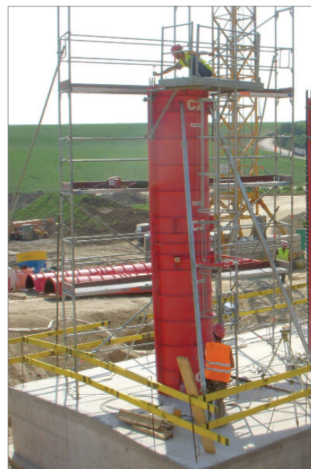
3. ábra Itt már a pillérek zsaluzása készül
