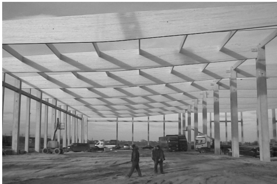
4. ábra Lapovo: vasbeton pillérek, ragasztott fa tartók
