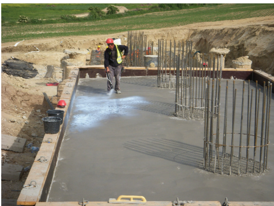
2. ábra A cölöpösszefogó gerenda betonjának utókezelése
