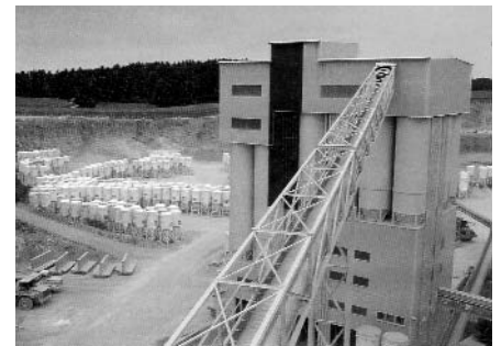
3. ábra Habarcsgyár látképe, a tárolóterületen a szárazhabarccsal feltöltött, szállításra váró silók
