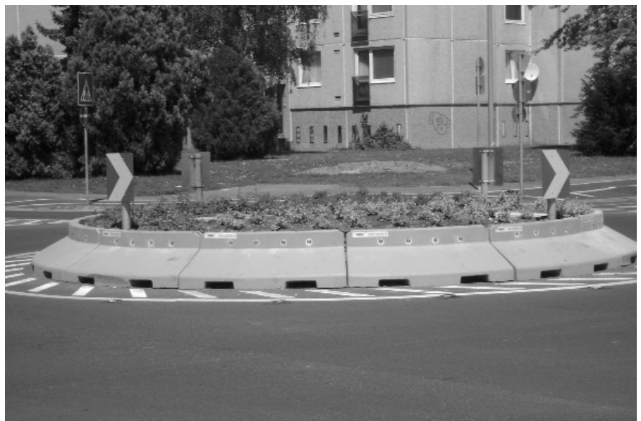
1. ábra Az előregyártott vasbeton elemekből kialakított középsziget növényzettel beültetve
