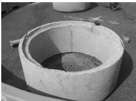
3. ábra A középszigeten belüli csatorna akna magasítása kútgyűrűvel
