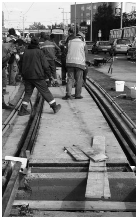
5. ábra A vágány elhelyezése
