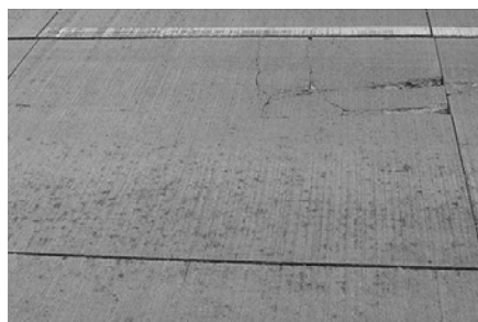
5. ábra Az első tönkrement tábla
