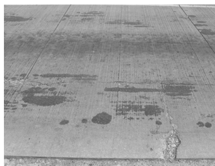
8. ábra Lámpa előtti törött tábla
