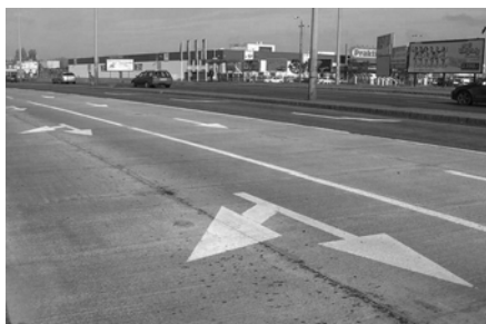
1. ábra Az elkészült betonburkolatú kísérleti szakasz
