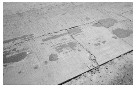
6. ábra Lámpa előtti tönkrement tábla
