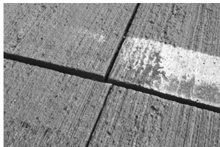
3. ábra Elcsúszás függőlegesen
