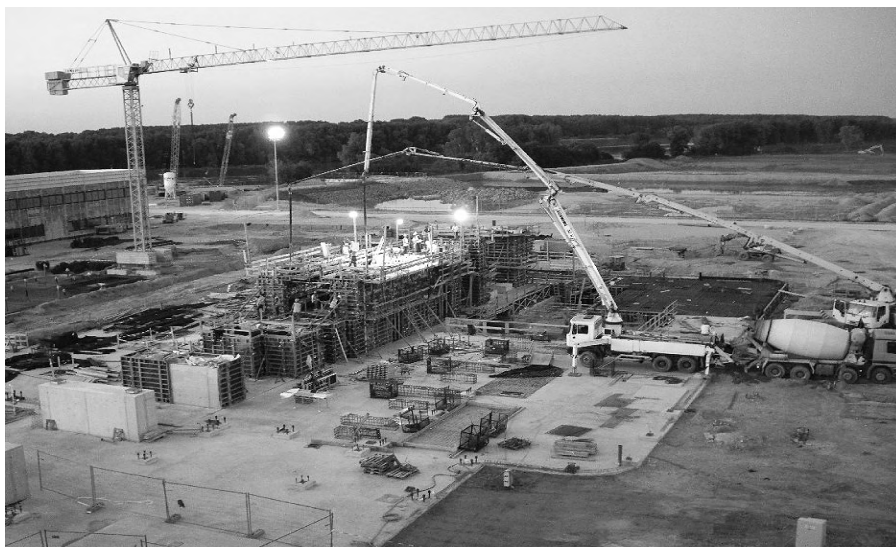
7. ábra A középső felépítmény betonozása
