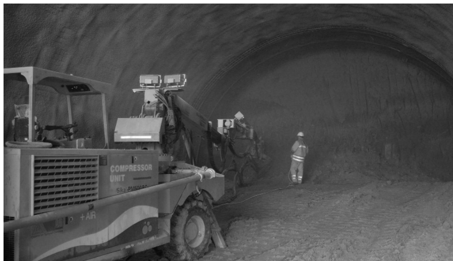
2. ábra Betonlövés Sika PM 500 PC típusú berendezéssel
