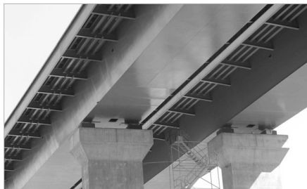
8. ábra A szebényi-völgyhíd korrózióvédő bevonattal ellátva
