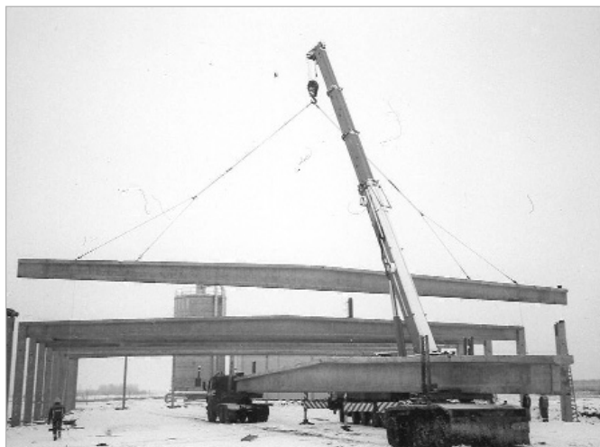
2. ábra A fertődi Velux raktárcsarnokának 32 m feszítávú tetőszelemenjei 2002-ben
