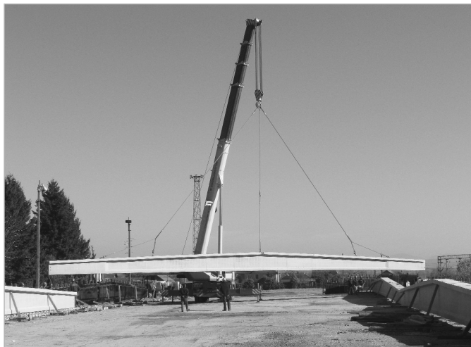
5. ábra 35 m fesztávú gerenda áthelyezése az AsaIbelik gyártótelepén
