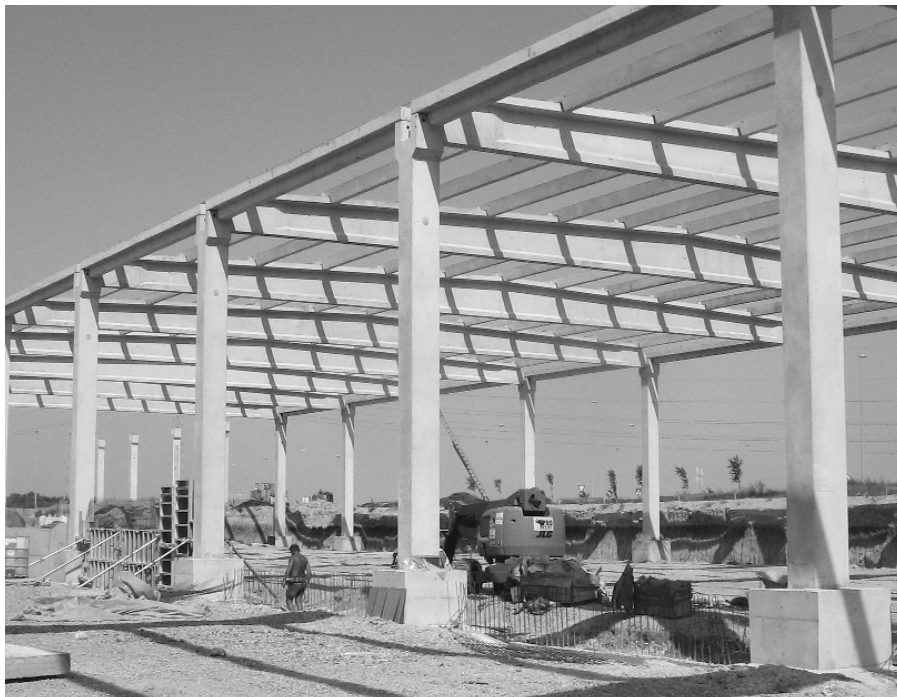
3. ábra A Fulgar cérnagyvár nagybecskereki, 30x12 m pillérállású gyártócsarnoka 2007-ben
