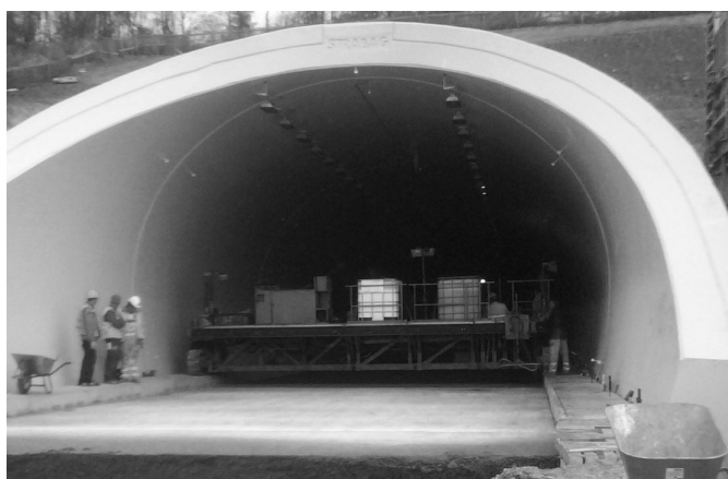
7. ábra A pályaszerkezet betonozása
