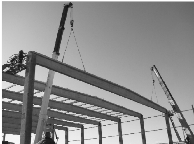
6. ábra Az Isomat 35x6 m pillérállású raktár-csarnokának szerkezete szerelés közben 2009-ben
