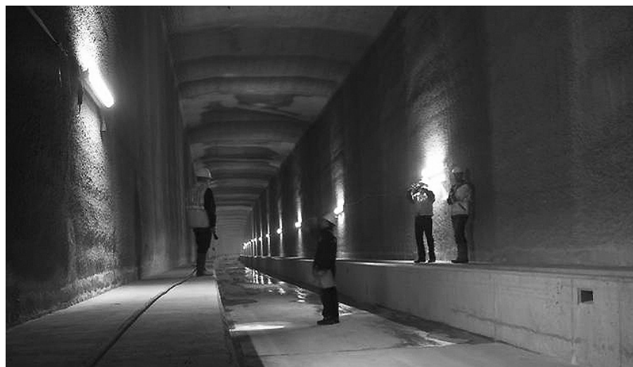
1. ábra A Söderleds főút alagútja Svédországban
