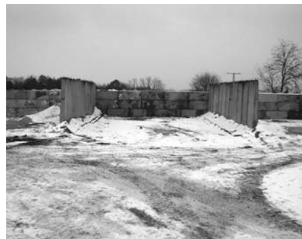
2. ábra A dunaiújvárosi betongyár kavics tárolójának hátfala 90 db elemből készült el
