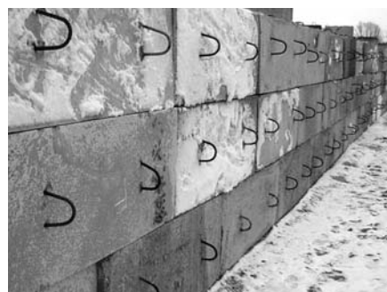
3. ábra Kötésben illeszkedő, egyenként 3,5 tonnás ILLEGO elemek
