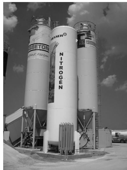
1. ábra Betongyári installáció
