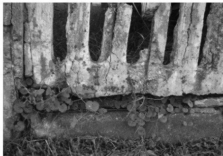
1. ábra Karbonátosodás, fagyás és gondozatlanság okozta mállás
