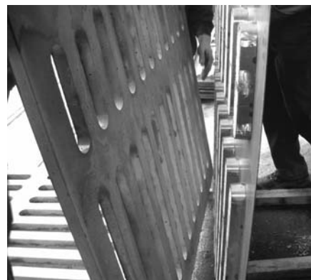
9. ábra Az elemenként 22 áttörést tartalmazó kerítésmező
