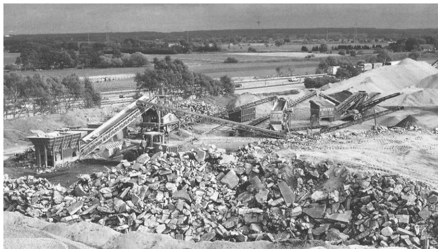
1. ábra Bontott betonburkolat újrahasznosítása
