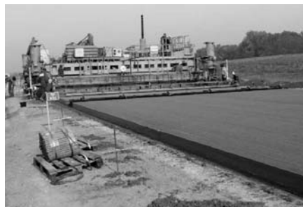
6. ábra A főpálya építése
