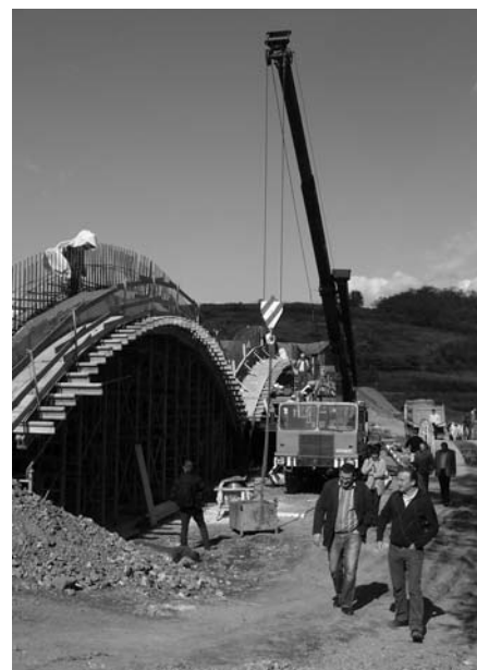
2. ábra Az Ipolyon újjáépülő híd és a látogatók
