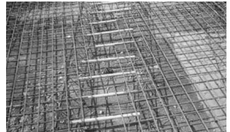
7. ábra Betonacél háló - a hézagokban keresztézag vasakkal
