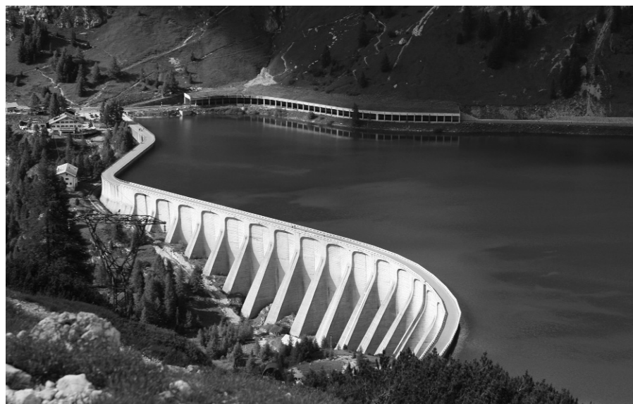
2. ábra Völgyzárógát Sika ViscoCrete technológiával megépített betonszerkezete
