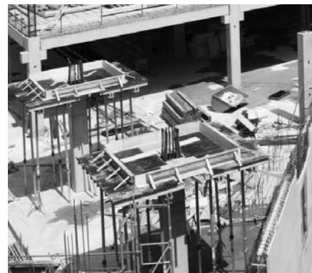
3. ábra Betonozásra váró szerkezet
