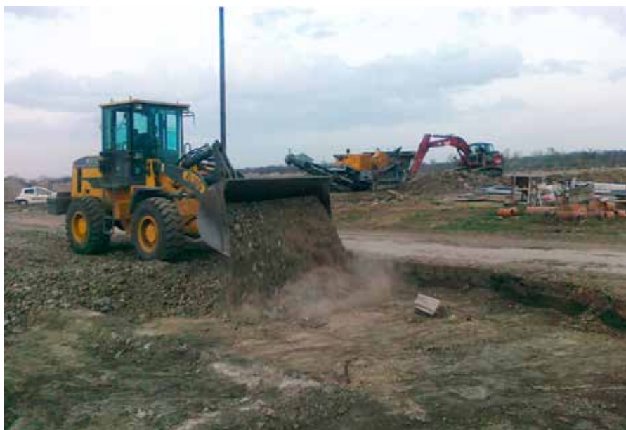
▲ Útalap készítése hasznosított építési-bontási hulladékból
