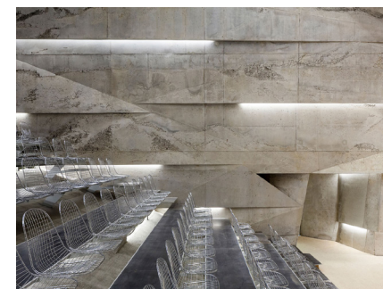
A koncertterem belső falkiképzéseinél a szürke beton látványát a felületeken látványosan képzett fészkeség oldja. Külön érdekesség a fény beáramlása a betoncsíkok között.
