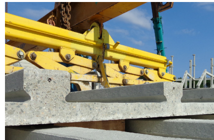
Felülbordás elem beemelő szerkezet
