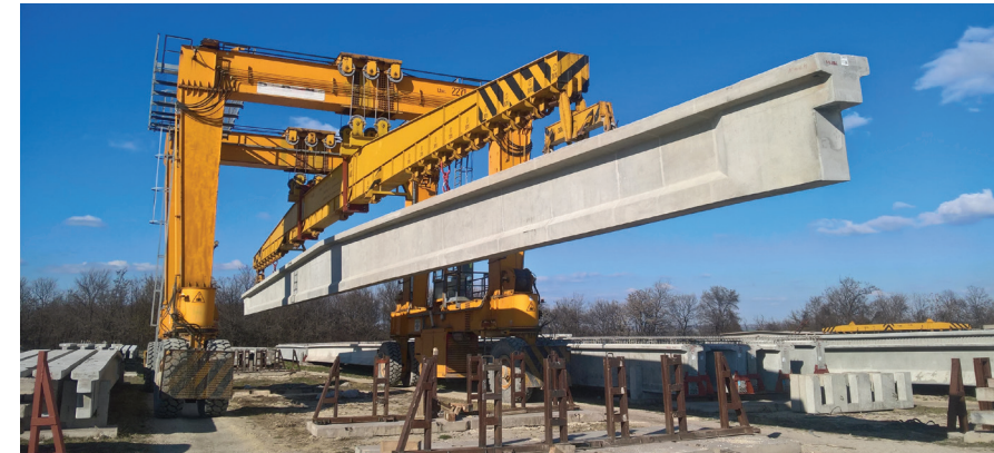
A tetőgerendák rakodása és deponálása a gyártóterületen
