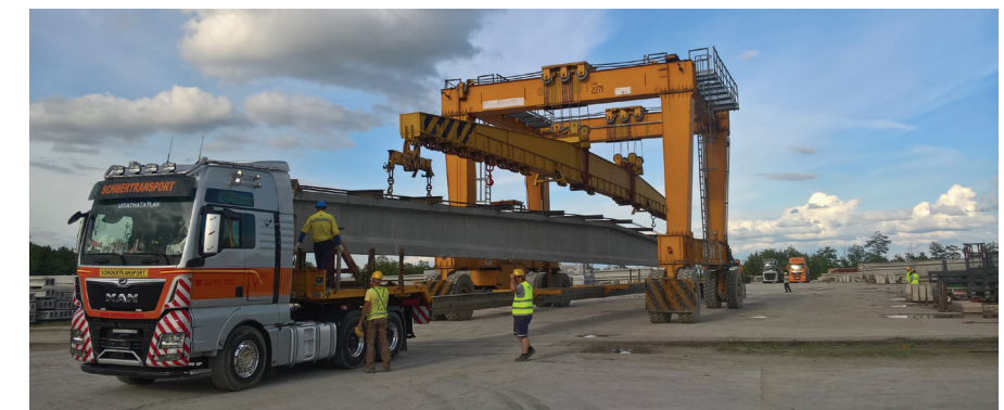
A közúti szállításra kész tetőgerendák
