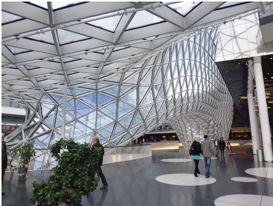
2. kép A MyZeil bevásárlóközpont héjszerkezetének belső képe
