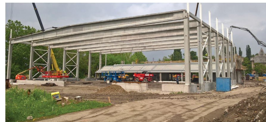
A tetőgerendák elhelyezése, szerelése
