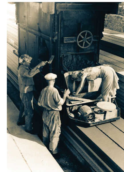
Beton tetőgerenda gyártása a leimeni betongyárban 1940 körül
