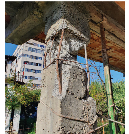
3. ábra Oszlopfej tönkremenetele elégtelen nyírási vasalás miatt (fotó: dr. Joó Attila)
