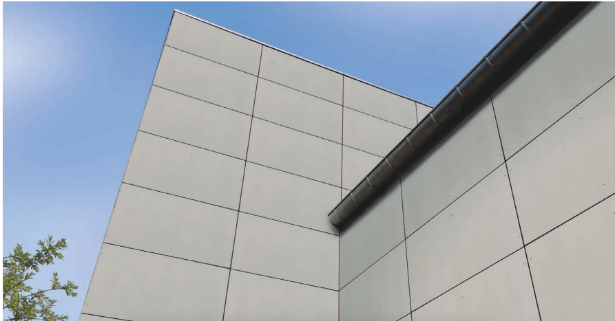
Szálcement burkolólemez 32 MPa hajlító-húzószilárdsággal
