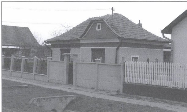
19. kép. 60-as években épült sátortetős ház csonkakontyos oromzat-kiegészítéssel, vasbetétes betonkerítéssel. Dózsa György utca. (Kolozsvári I. felv., 2005)
