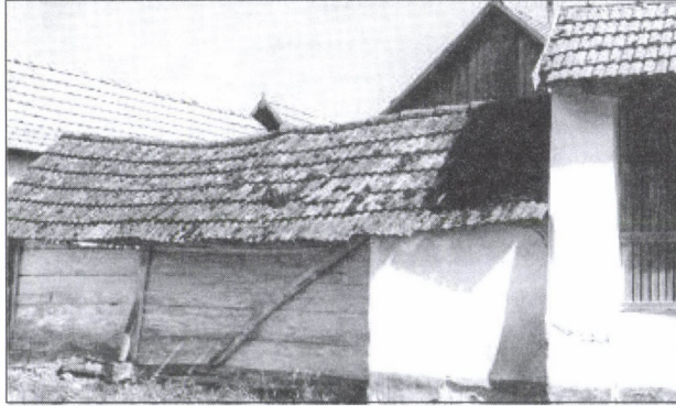
25. kép. Utcafrontra, egybeépített deszkadisznóól és vályogfalú baromfiól, valamint kőlábas góré. Az ólakat Mózer-féle cementcserép fedi. József Attila u. 5. (Pataky Emőke felv., 1995)
