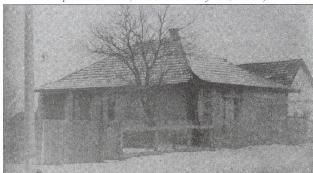
6. kép Vályogból épülő sátortetős lakóház (Kocsi Gyula felv. Forrás: M. Sipos E.: 1963. 46.)
