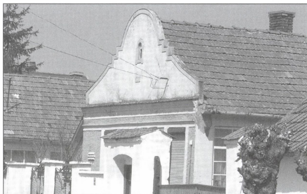
12. kép. Barokkos oromzatú, felújított lakóház. Petőfi utca (Kolozsvári I. felv., 2005)
