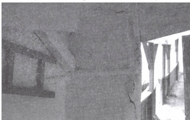
5. kép. Régi típusú zsellérház tornácából leválasztott kamra kórópaticis fala. Árpád u. 103. (Kolozsvári I. felv., 2004)
