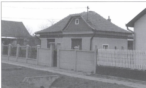
19. kép. 60-as években épült sátortetős ház csonkakontyos oromzat-kiegészítéssel, vasbetétes betonkerítéssel. Dózsa György utca. (Kolozsvári I. felv., 2005)
