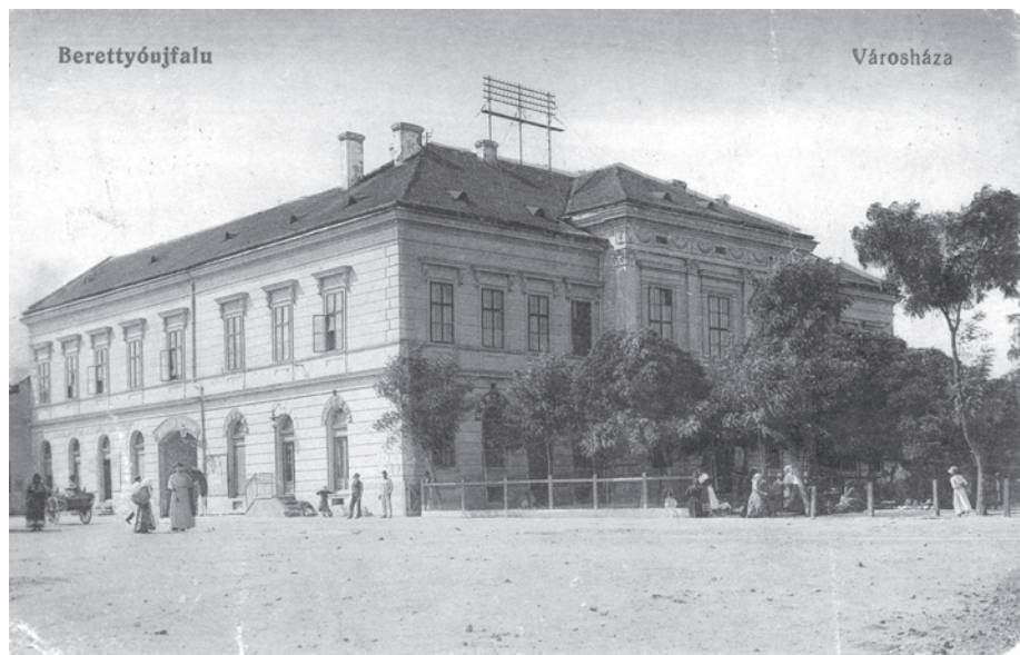
1. kép. Berettyóújfalú községháza
