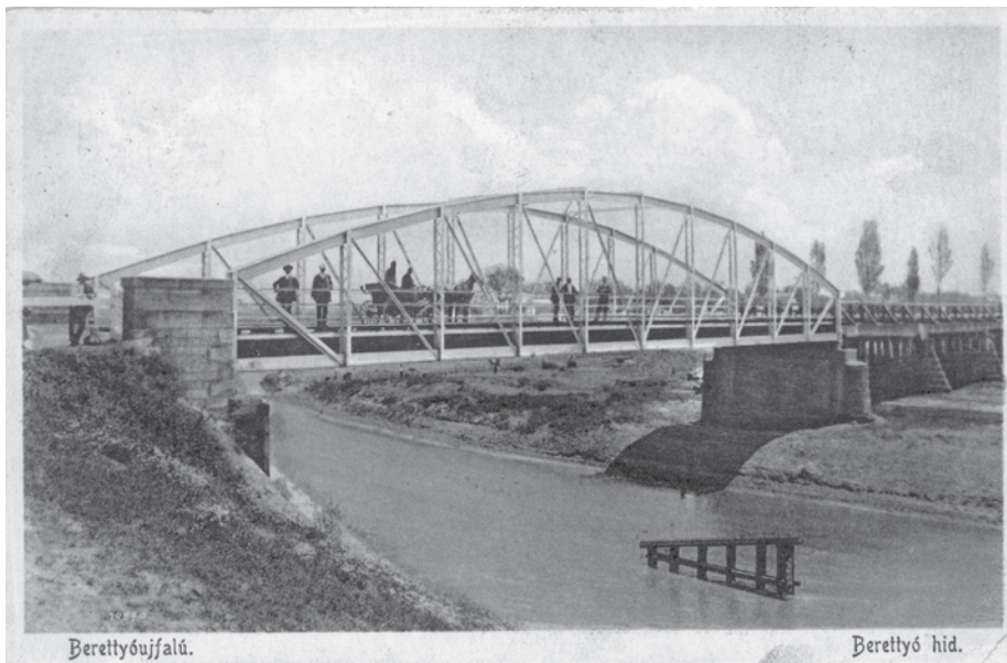
6. kép. Berettyóújfalú, Berettyó-híd
