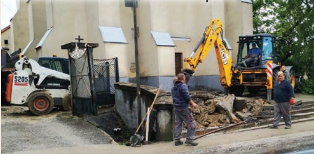
A Trans-Motors Kft. bontotta a betonlépcsőt
