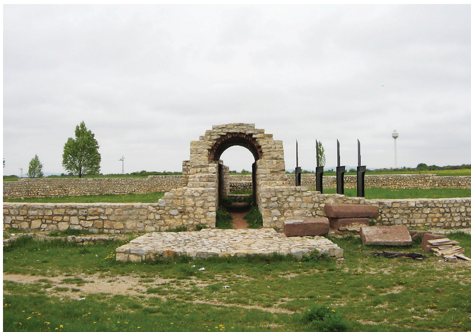
1. kép. A balácai halomsír a műemléki helyreállítás után
