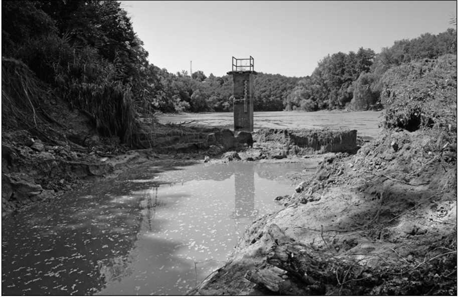
7. számú ábra: Galambok településen található tározó átszakadt töltése. Forrás: A szerzők saját szerkesztése
