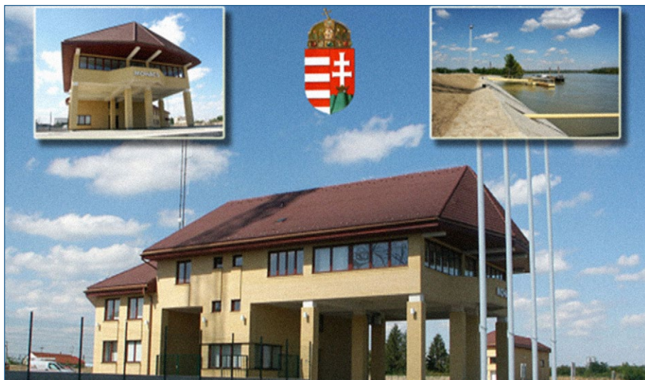
2. számú ábra: A Mohács Vízi Határátkelőhely épülete
