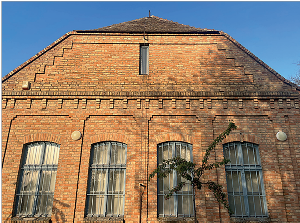
A sósalmi tanyai iskola épülete
