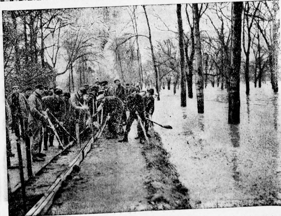
Dessau mellett a technikai csapatok dolgoznak az árviz megakadályozásán
