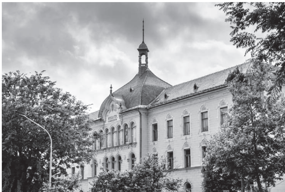
Az iskola épülete 2020-ban
