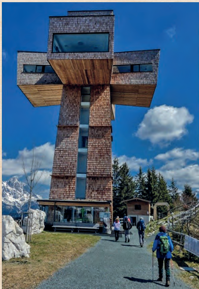
Keresztformájú kilátótorony az Alpokban teljes egészében kezeletlen vörösfenyőből. A legértékesebb fa építőanyag.
