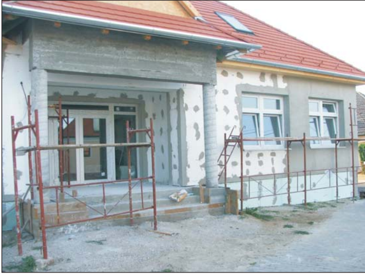
Az egykori iskola épületének felújítása.
