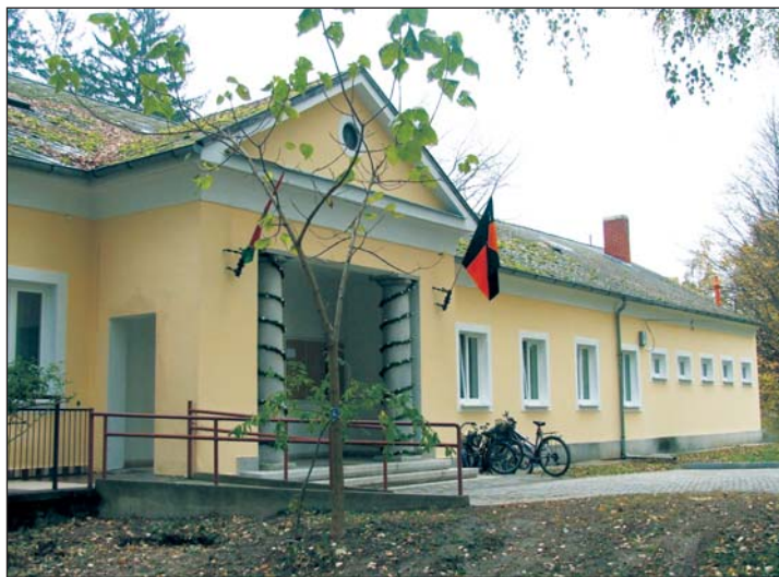
Kívül is megújult a Kolping Kárpáti utcai épülete.
