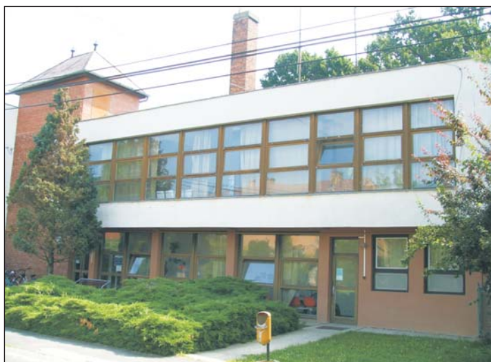
Ilyen volt a letenyei rendelőintézet a felújítás előtt.
