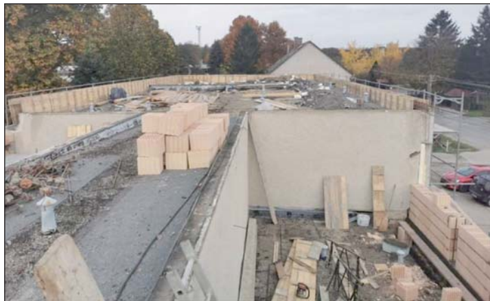
Napelem kerül az új tetőre, így a saját energiaszükségletét fedezni tudja majd az önkormányzat épülete.
