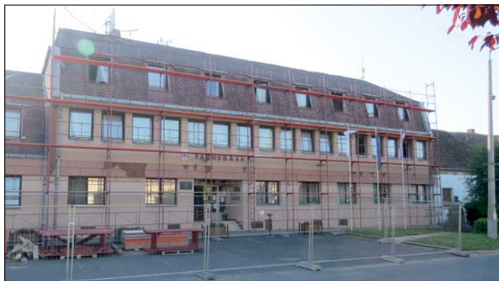
A felújítás előtt álló, felállványozott letenyei városháza.
