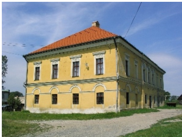
(5.) Uzapanyit. Máriássy kastély. 18. században emelt épületet egy évszázaddal később emeletesre bővítették. Az alsó szint ablakait eredeti méretükben megtartották, hogy ne gyengítsék a meglévő boltozatok alátámasztását. Az alsó szint nyílászáróit boltvállakra ültetett íves szemöldökpárkányokkal arányosították az emeletiekhez. Erőtéljes szintosztó párkány, valamint az ablakok díszítése hasonló formában, több Miks Ferenc alkotásának vélt épületen megtalálható.
