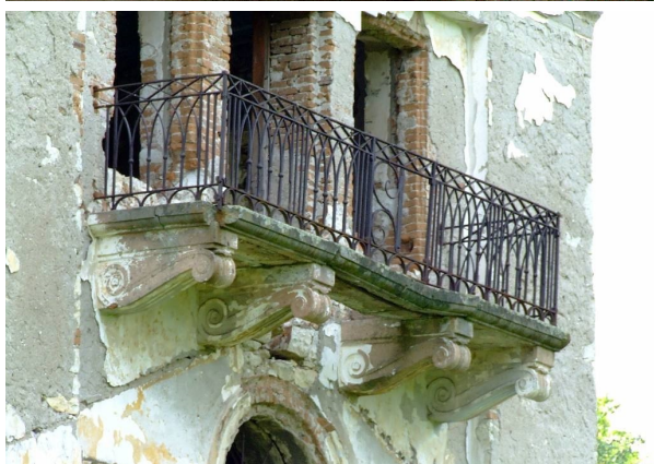
(23.) Légfűtés tüzelőnyílása a pincében. Alul főhomlokzati közép rizalit faragott kő konzolai.
