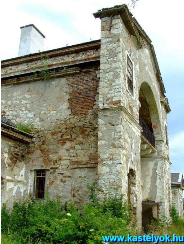
(22.) Udvari homlokzaton további szép és hazánkban különlegesnek számító részleteket találunk.
