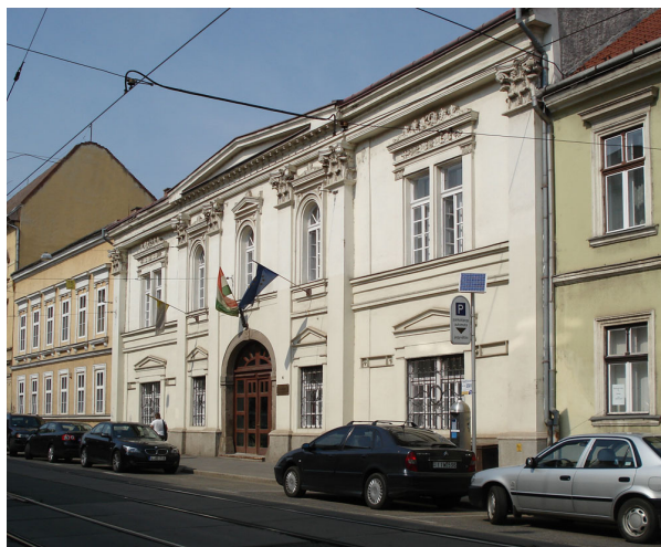
(10.) Miskolc, Hunyadi u. 6. szám. Korábban Szathmáry, ma Báji-Patay kúriaként ismert épület homlokzata igazoltan Miks Ferenc műve. Pillérfejezetek, a díszítő „etruszk motívumok”, valamint a hangsúlyozott szintosztó és könyöklő párkányok motívumait a mester más művein is megtalálhatjuk.
