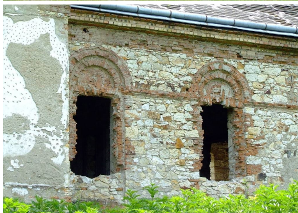
(24.) Eredeti vakolatuktól megfosztott épületeken jól kivehető faragott és vegyesen rakott kövekből, valamint égetett téglából rakott, 19. századi falazási technikák.
