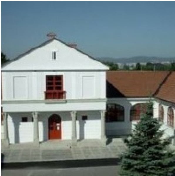
(19.) Felsőzsolca. Szathmári Király – Bárczay kastély udvari homlokzata ma. Szerényebb méretek ellenére is jól látható a venetói villákra emlékeztető „palladiánus” épület szerkezet.
