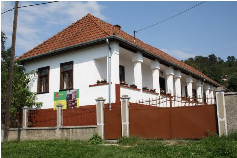
Felújított parasztház Szendrő központjában, az iskolatörténeti kiállítás épülete
