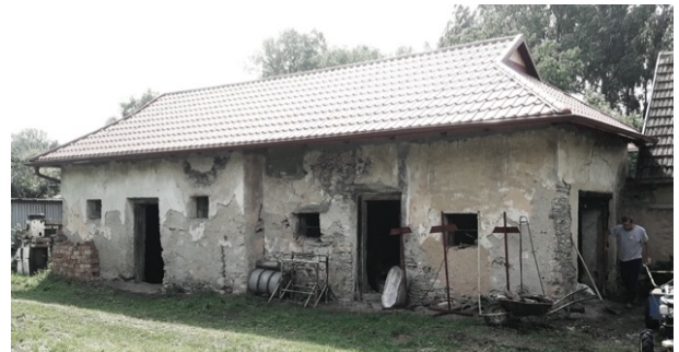
Az eredeti épület
