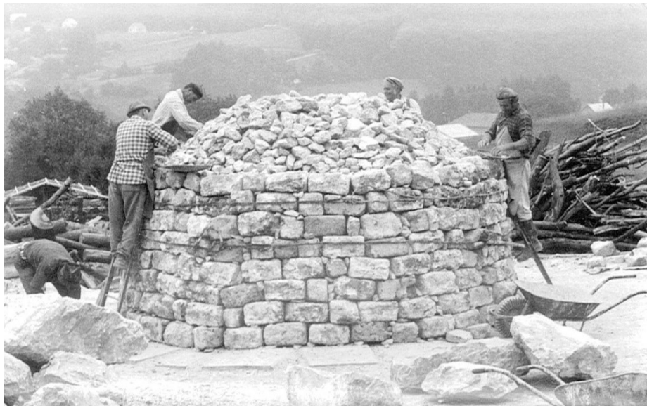
Mészkemence építése az 1970-es évek végén a Bükkben.
