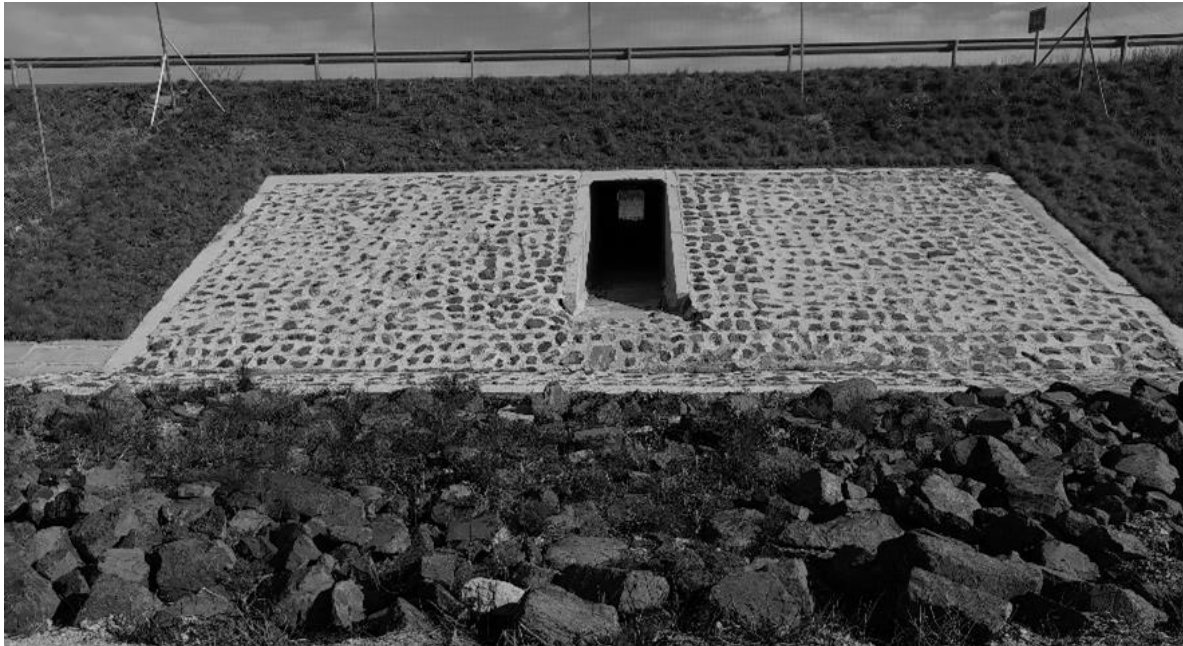
1. ábra: Vizsgálatba bevont közúti műtárgy képe
