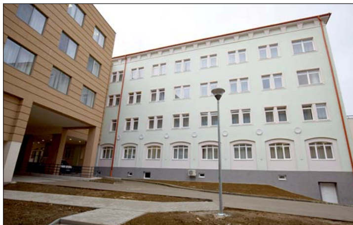
Szemben a felújított épület.
