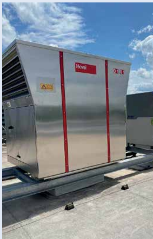
Légkezelő külső egység és hőszivattyú
