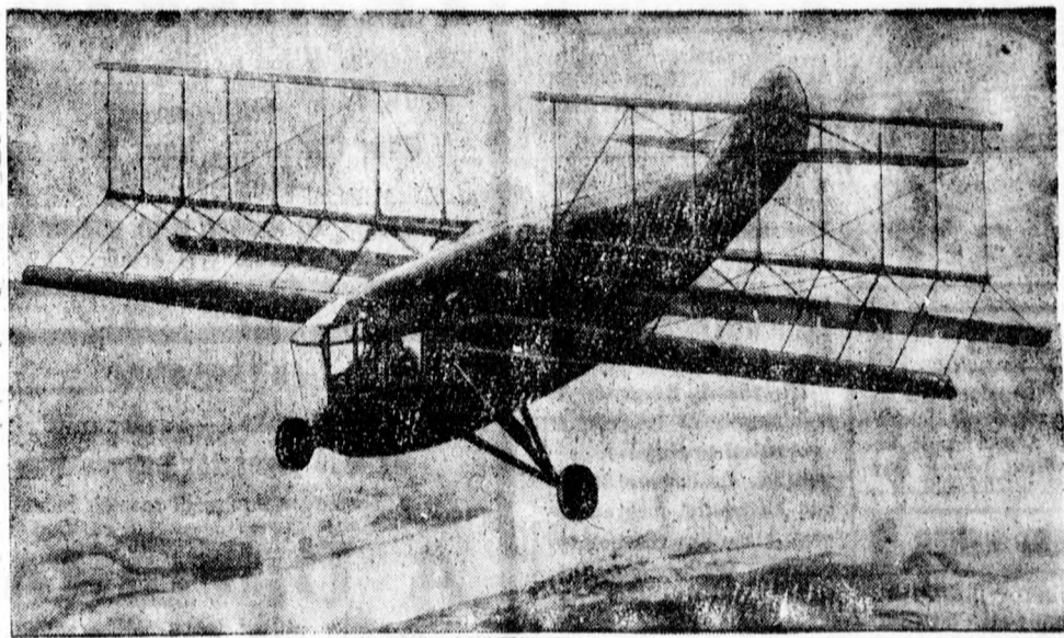
Repülőgép hajókerékszerű szárnyakkal. A berlini Rohrbach művekben most újfajta repülőgépet készítettek. A repülőgépnek hajókerékszerű szárnyai vannak, amelyek forognak és úgy uszlik a levegőben
