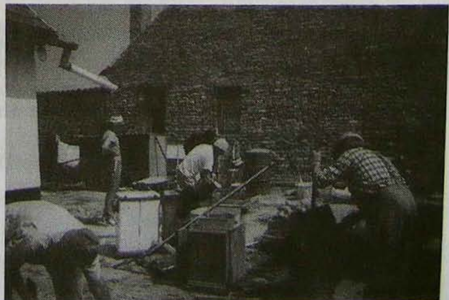
1997. tavaszi közmunka, a melléképületek lebontása.
